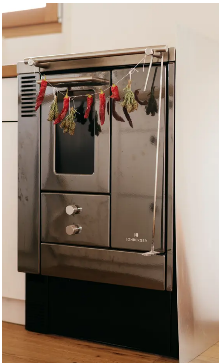
Einer der beiden Holzöfen: gleichzeitig eine Art Boiler fürs Warmwasser.
